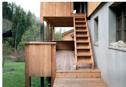
Die Terrasse wurde verbreitert. Die alten Säulenbalken verlängert.
