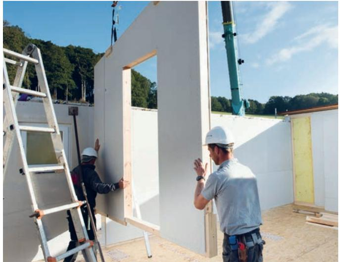
fermacell® Gipsfaser-Platten, für den schnellen und hochwertigen Holz- und Trockenbau sowie als Brandschutzplatte sind zentrale Verwendungen bei Neubau- und Renovierungsarbeiten.
