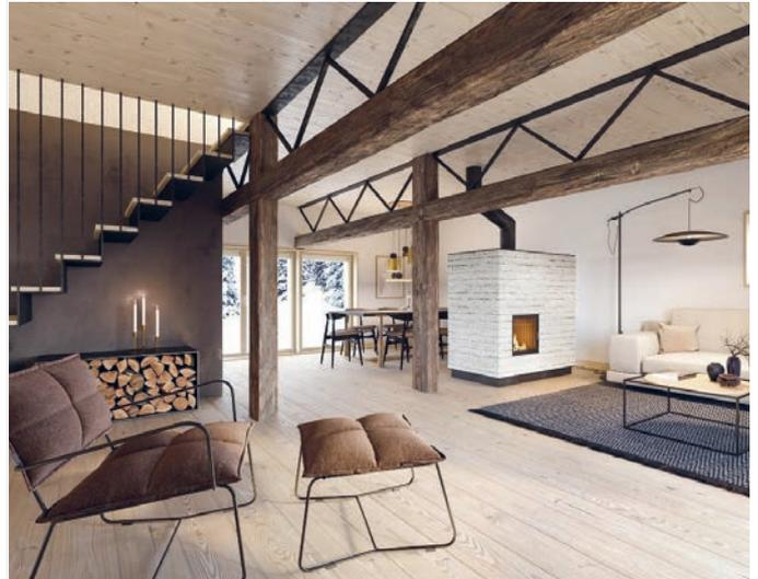
Moderner Metallbau mit aufgehängter Treppe, Absturzsicherungen und Aussteifungen als Verbundträger in rohem Stahl in einem Stallumbau in Reckingen (Architektur Egger)
