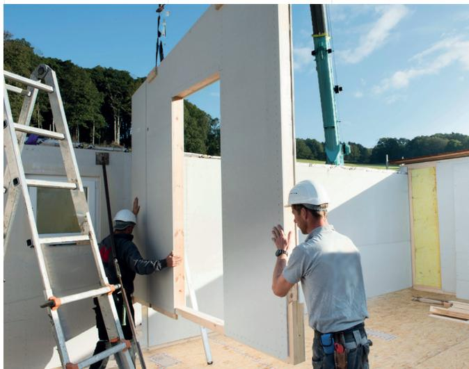
Les plaques de plâtre armé de fibres fermacell®, pour la construction rapide et de haute qualité en bois et à sec, ainsi que comme plaque coupe-feu, sont des utilisations centrales dans les travaux de construction et de rénovation.
