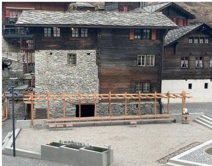
Maison d'habitation datant de 1631, dont on suppose que la partie du mur provient des restes d'une ancienne tour de défense du 12e siècle. Rénovation totale des combles, du toit et de la façade.
